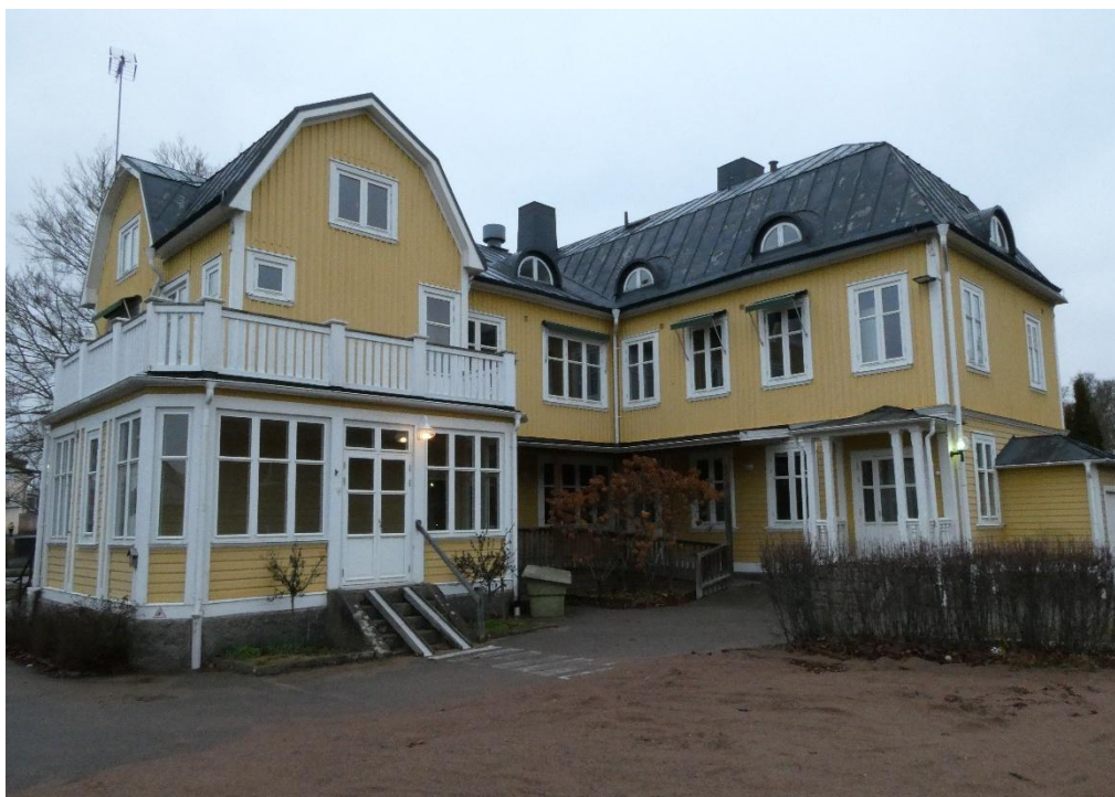
Fastigheten från sydöst. I bottenplan skymtar det sentida tillägget med skärmtak och ramp.
