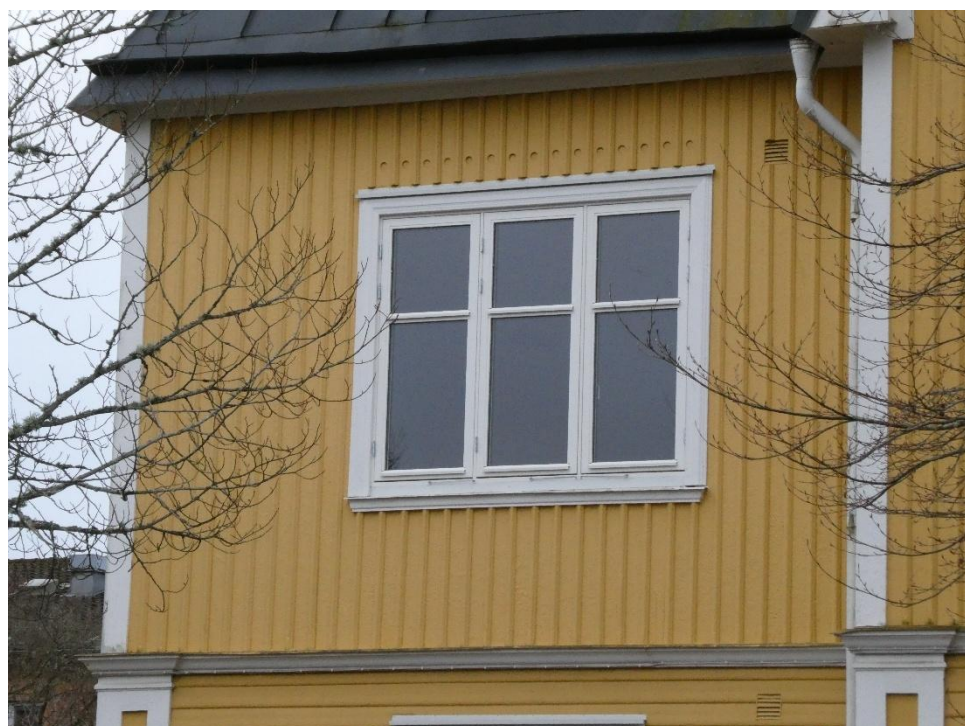
Figursågad dekor i form av cirklar på fasadpanelen ovanför fönstret.
