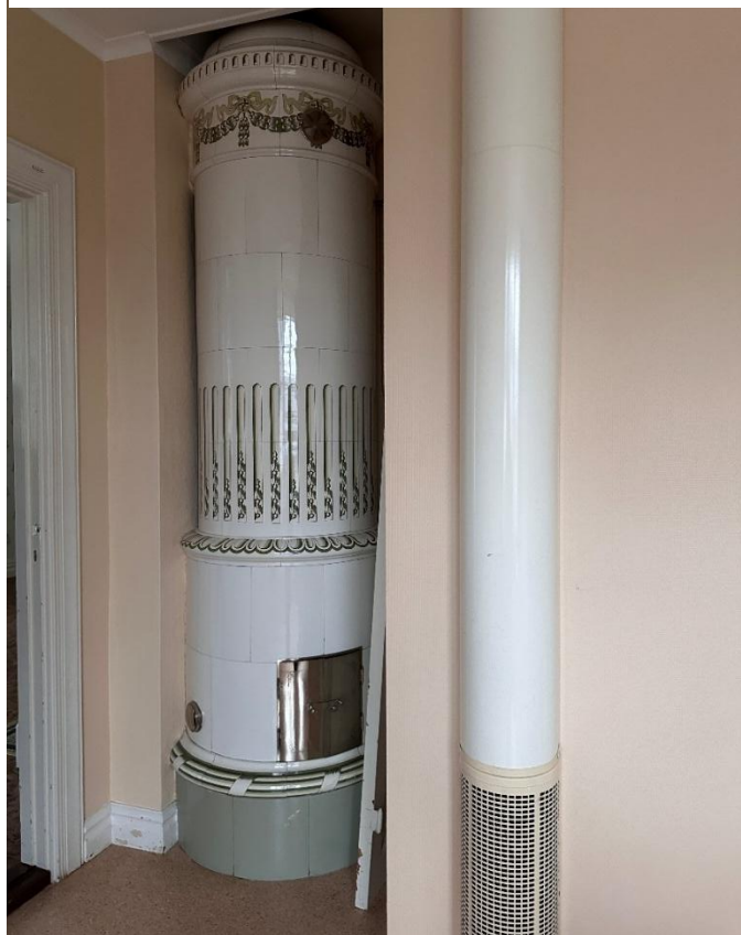
Nedre plan, herrum. Kakelugn bakom senare utbyggd vägg.
