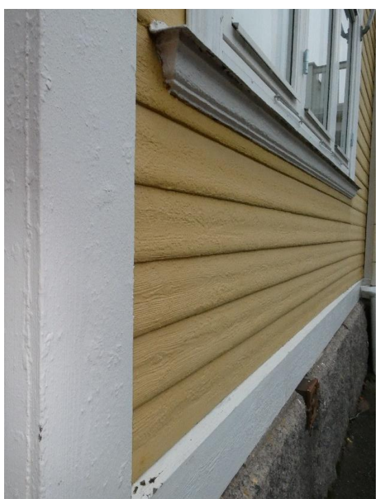
Detaljbild över ursprunglig päronformad panel samt fönsterbräda i original.
