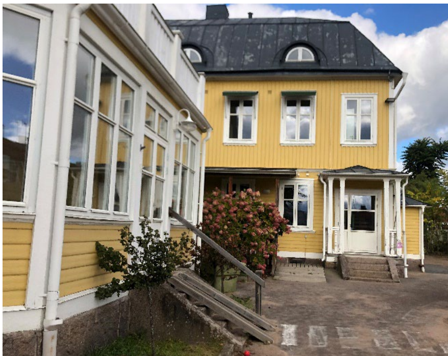
Figur 31: Bilden visar rampen som finns på baksidan av byggnaden mot innergården
