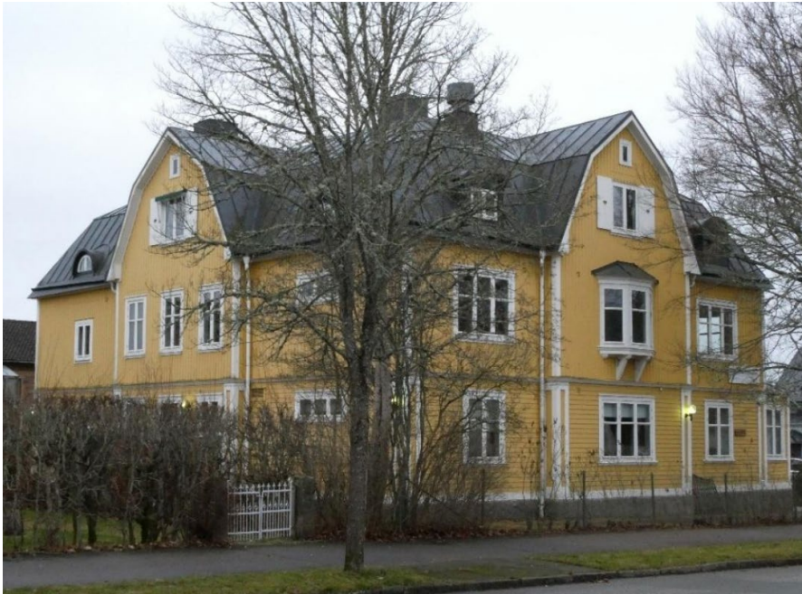
Figur 20: Bilden visar villan inom den aktuella fastigheten Mohagen 21 sett från Stationsgatan
